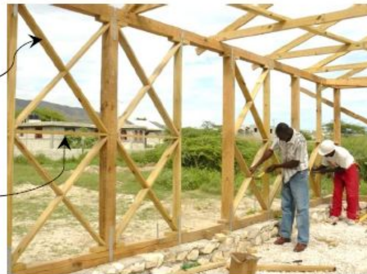
Lisses intermédiaires divisant les panneaux en hauteur
