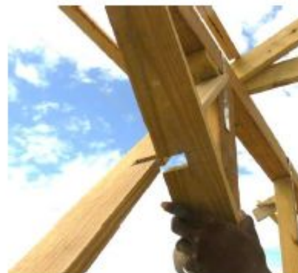
Assemblage avec entaille à mi-bois
