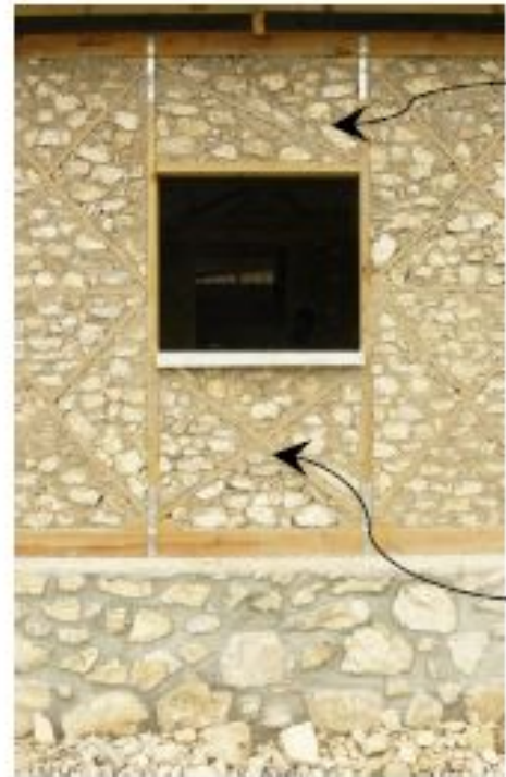
Contreventement des panneaux d'angles avec fenêtres
